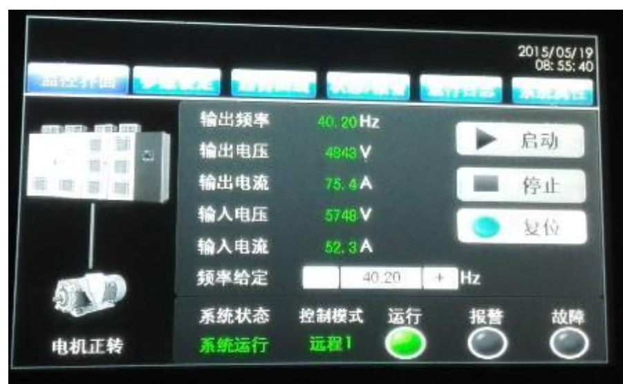
图 9 现场运行状态照片
