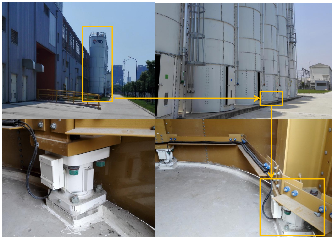
图 4：LoadStand II 传感器安装效果
