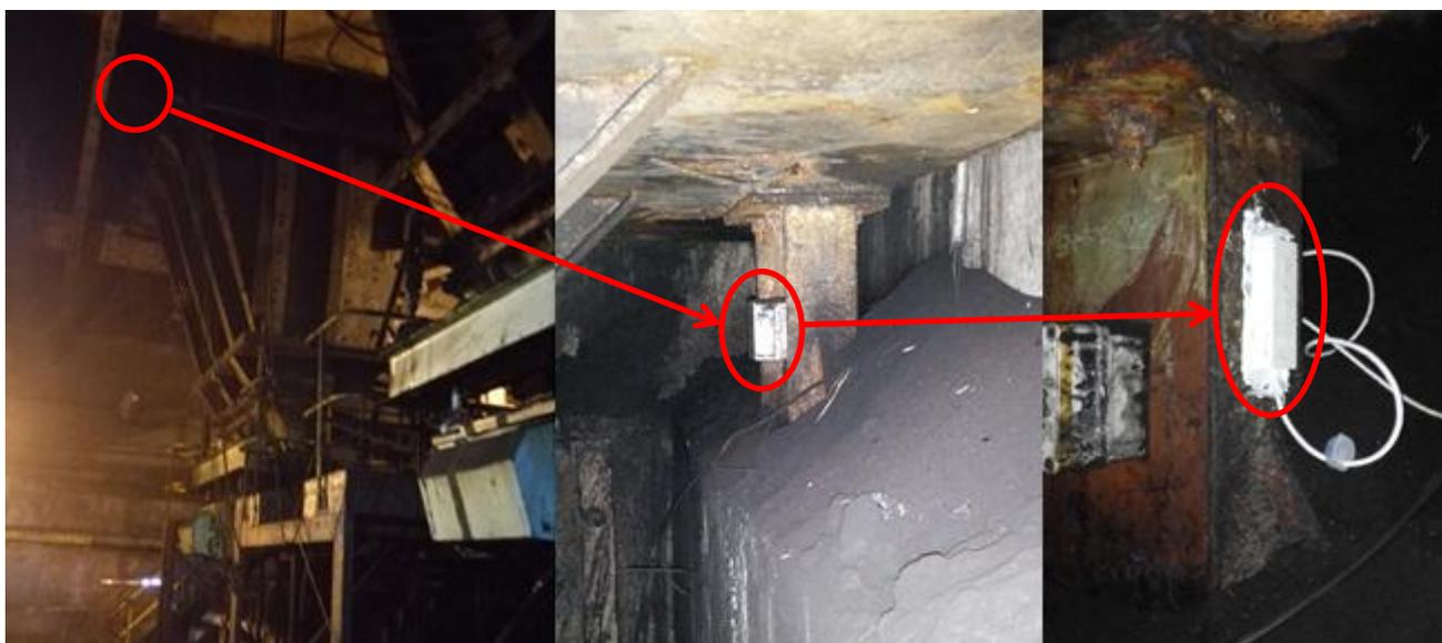
图 4：贴片式传感器安装实际效果
