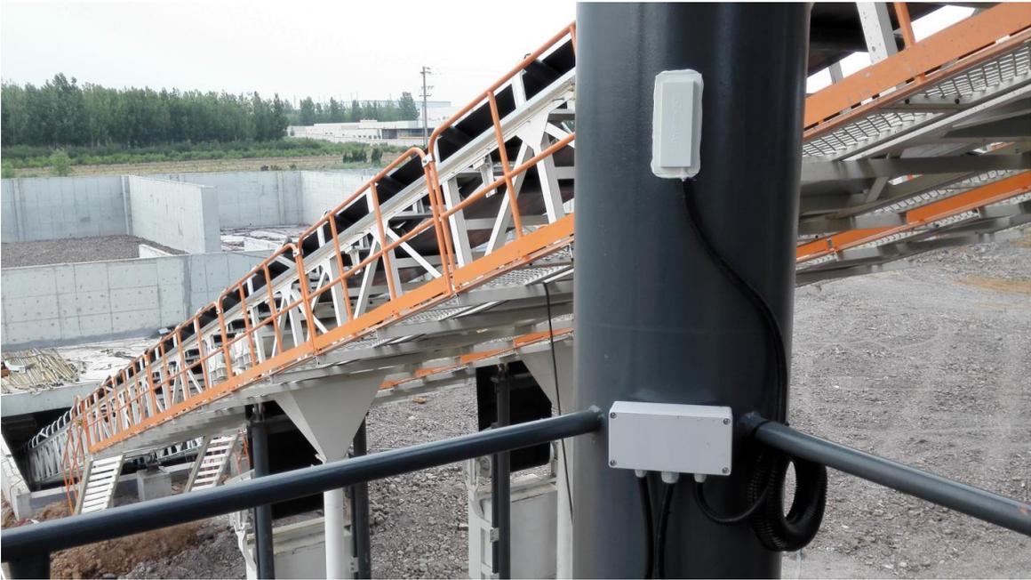
图 7：贴片式传感器安装效果
