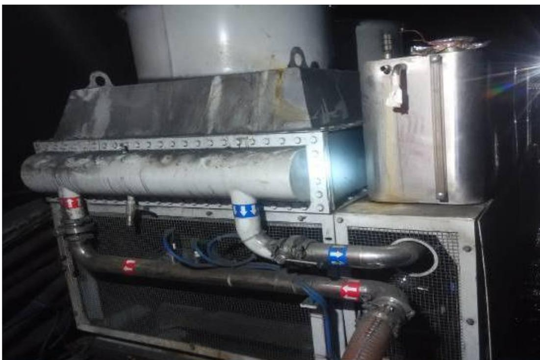
图 14 变频器外水冷系统图
