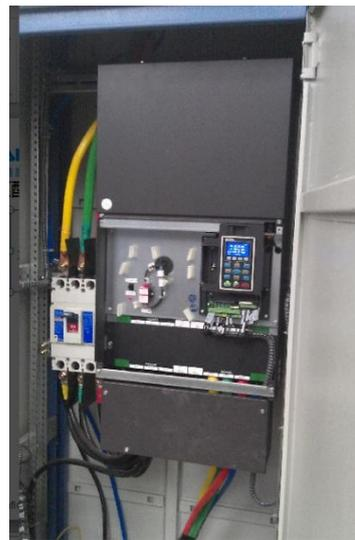
图 6 二级泵电控柜
